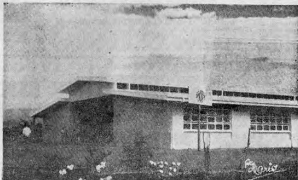
Escuela de Chacarita construida con el sistema de bloque de concreto. Consta de seis aulas, salón de actos, Dirección y "set" de sanitarios. Costó 125 mil colones. Mano de obra 43 por ciento
